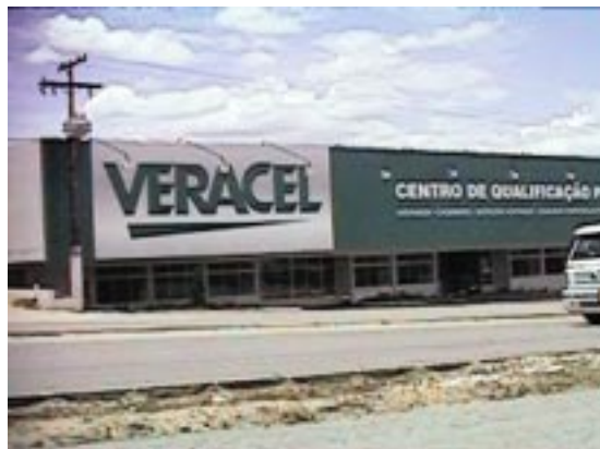
Participantes do intercâmbio conheceram os canteiros de obras da Veracel no sul da Bahia. Na foto acima, o centro de treinamento
